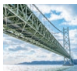
明石海峡大橋
