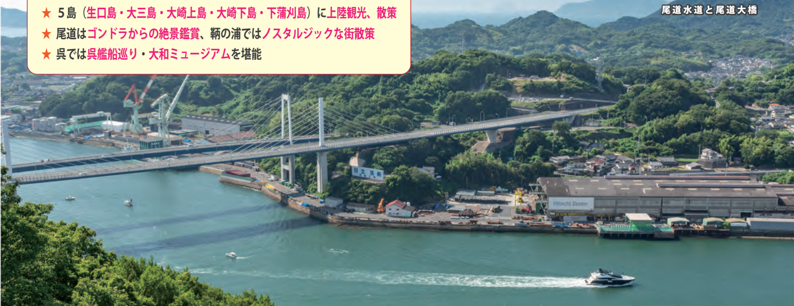
尾道水道と尾道大橋
