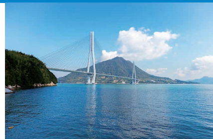
多々羅大橋
