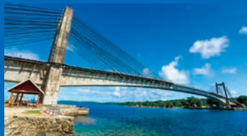
日本・パラオ友好の橋(パラオ)
